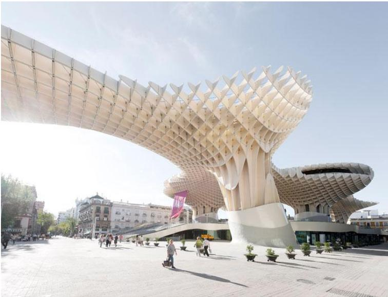
Figura 5. Exoesqueleto construido con madera laminada, para la Remodelación de la plaza de la encarnación. Sevilla. España. Arq. Jürgen Mayer. Foto: J. Mayer Arch.
