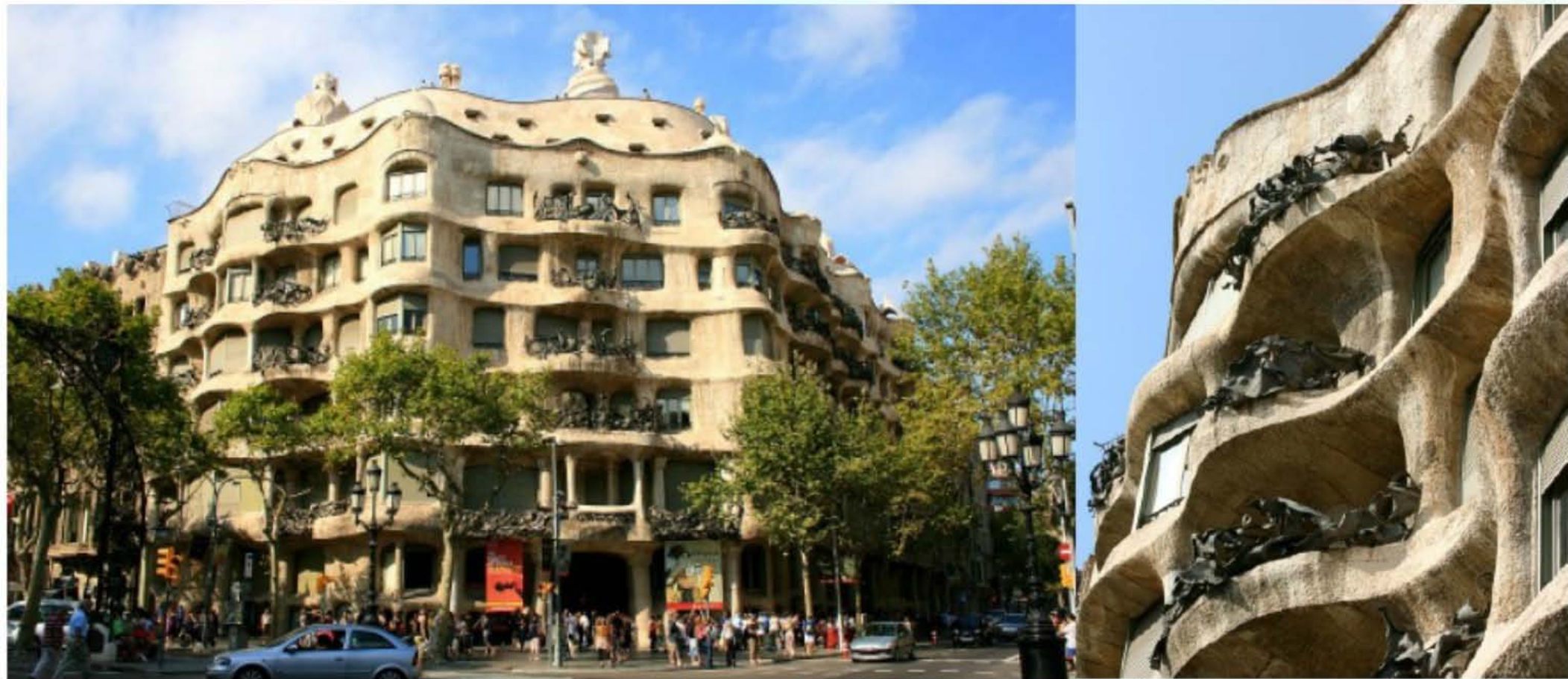
(6) (7) Vistas de la pedrera o casa Mila del arquitecto catalan Antonio Gaudi.
