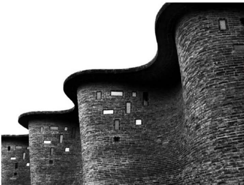
(2) Iglesia Atlantida. Construcción tradicional. Eladio Dieste.
