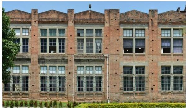
Para procesar el material fotográfico se utiliza el *software Adobe Photoshop*. A las fotografías (en formato RAW) se les ajusta la exposición y se les “*rectifican*” las verticales y horizontales. Mediante la función *photomerge* de *Photoshop* o manualmente, se unen todas las fotografías en un solo documento donde se representa una vista ortogonal de la fachada fotografiada.
