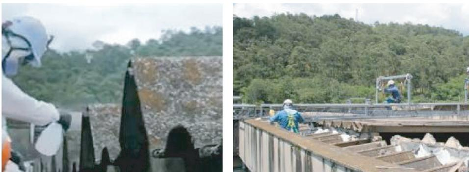
Figura 2.7 Proceso de diagnóstico y toma de muestras materiales para validar presencia de asbesto (izquierda) y desmonte de cubierta de asbesto cemento (derecha) en el bloque 46 de la UNAL, Sede Medellín
