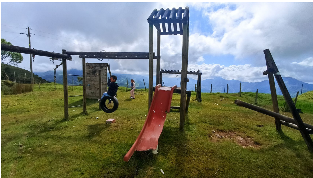
Figura 5-6. Fotografía que muestra parque infantil en mal estado, corregimiento de Buenavista, Toledo
