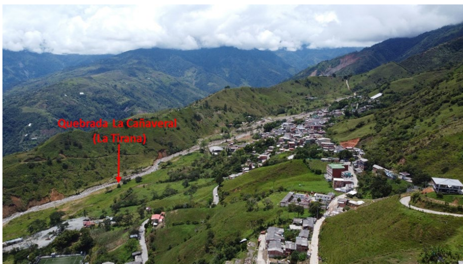
Figura 8-6. Fotografía panorámica de la cabecera municipal de Briceño vista en dirección sur
